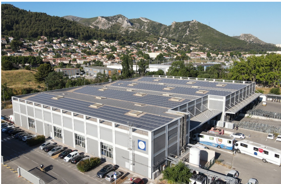
Le bâtiment, situé Parc de la Valentine, 41 chemin vicinal de la Millière à Saint Menet, Marseille 11 e , abrite notamment des services de la Poste ainsi que l'Établissement Français du Sang
